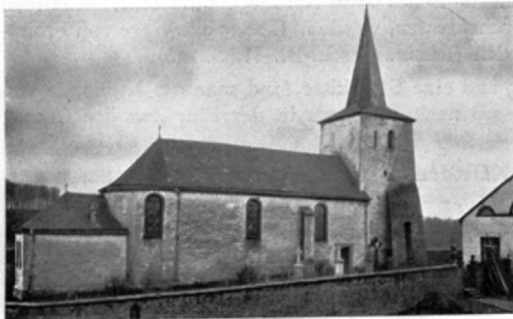
Fig. 82. Frohngau. Kath. Pfarrkirche. Alte Ansicht von Norden.
